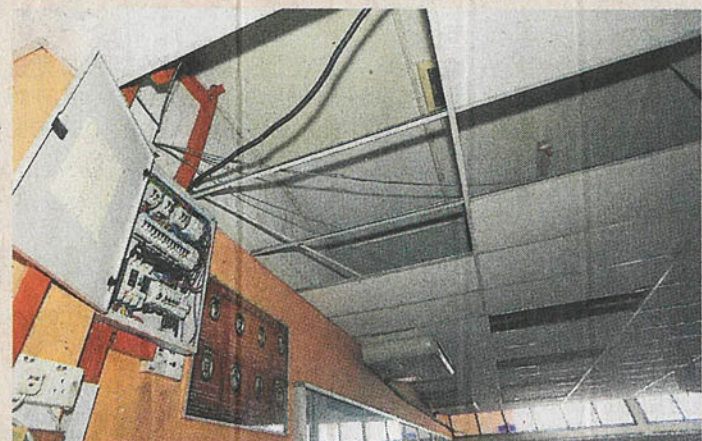
部门天花板还未安装上去。
