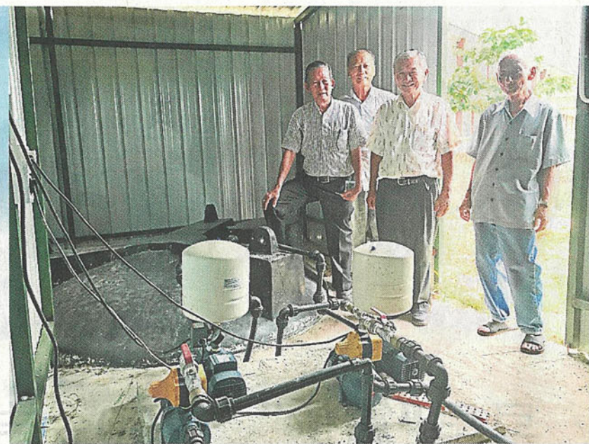
▲王建和（左一）与黄泽桂（右二）在村民的陪同下巡视临时搭建的水泵房。
