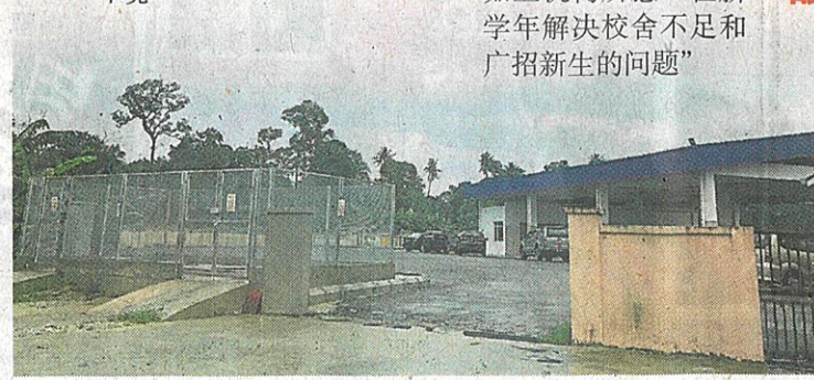
学校后门的变电房 (左) 已建竣，只需接驳电源即可启用。
